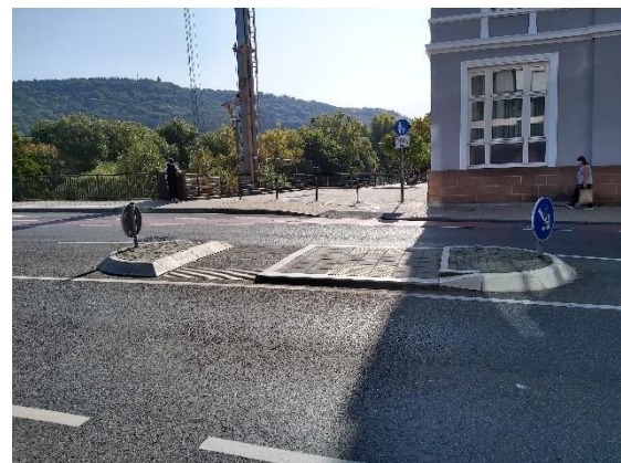
Abbildung 27: Barrierefreie Querungshilfe an der Bahnhofstraße
