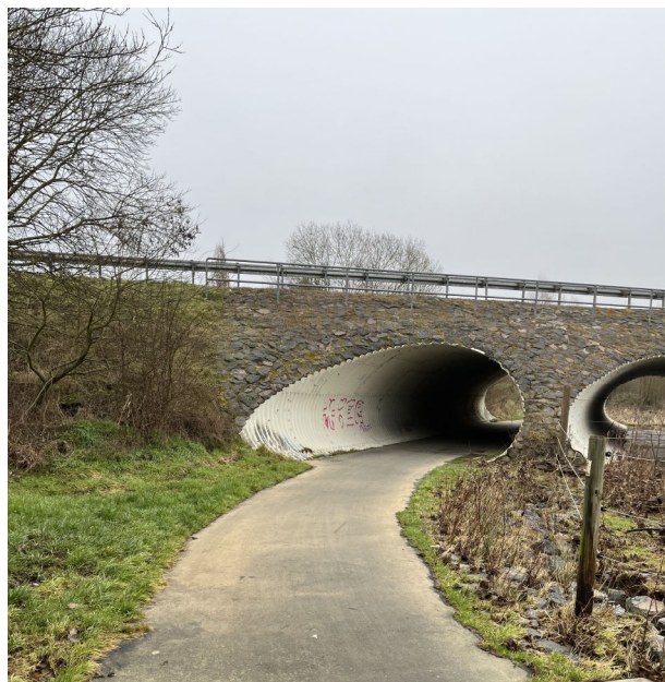
Abb.3 Straßendamm K79 mit Stahlwellprofile
