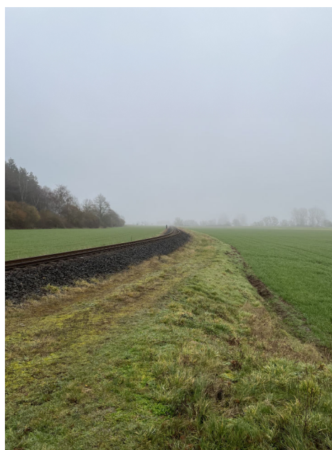
(Abb.11 – Vorhandene Gleise der Deutschen Bahn im Untersuchungsgebiet)
