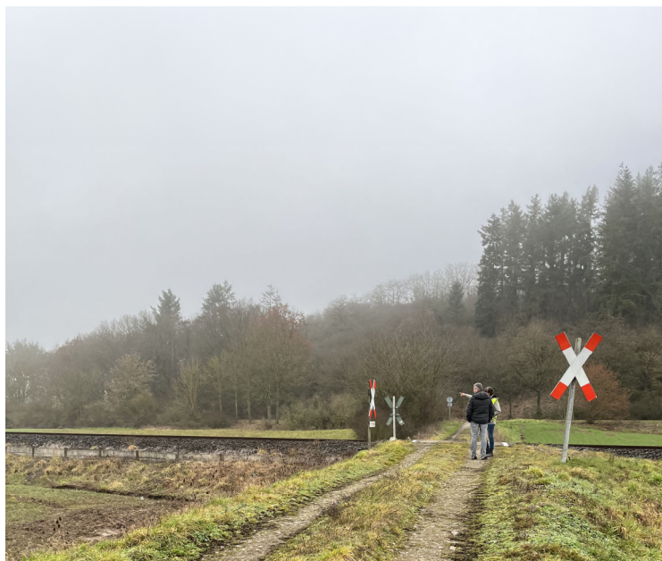
(Abb.8 – Vorhandener Bahnübergang St. 0 +307 m)
