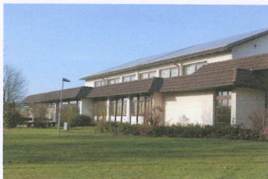
Ansicht von Süd-Osten
