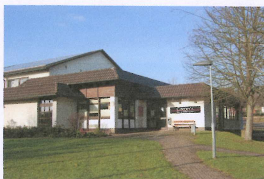
Ansicht von Süd-Osten
