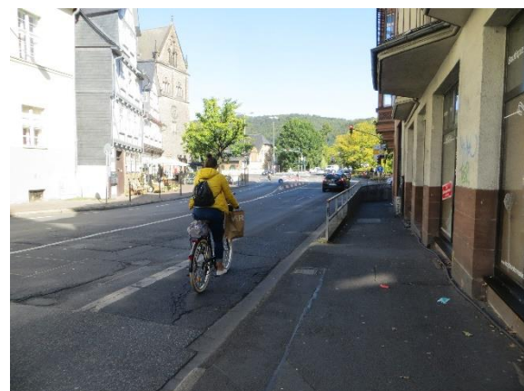
Abbildung 47: Fehlende Radverkehrsmarkierung und starke Unebenheiten (Universitätsstraße)
