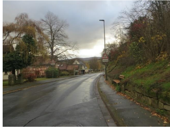
Abbildung 32: geringe nutzbare Gehwegbreite (Wehrhäuser Straße, Wehrshausen)
