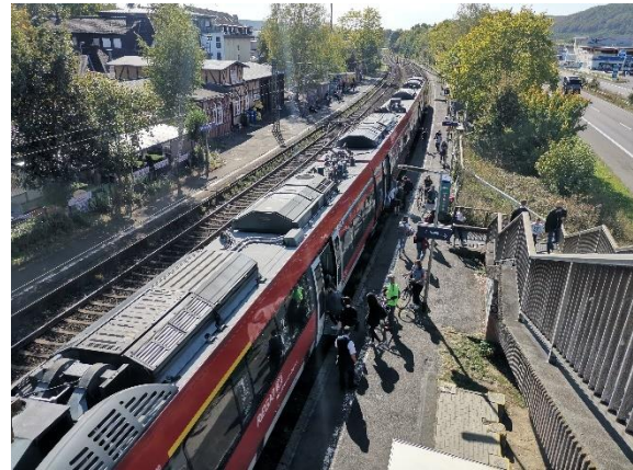
Abbildung 61: Bahnhof Marburg (Süd)
