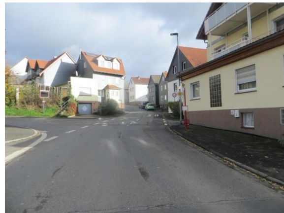
Abbildung 43: fehlende Radverkehrsinfrastruktur in Bauerbach (Bauerbacher Straße)
