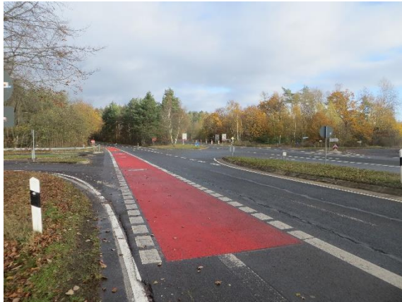
Abbildung 40: Radverkehrsinfrastruktur an Hauptverkehrsstraße (Auf den Lahnbergen)
