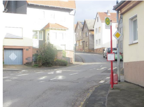
Abbildung 63: Nutzungskonflikte & beengter Raum im Bereich einer Bushaltestelle (Bauerbach)
