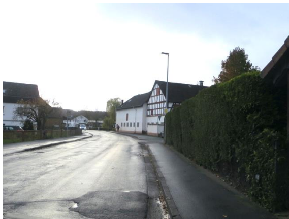
Abbildung 42: fehlende Radinfrastruktur in Elnhausen (Königstraße)
