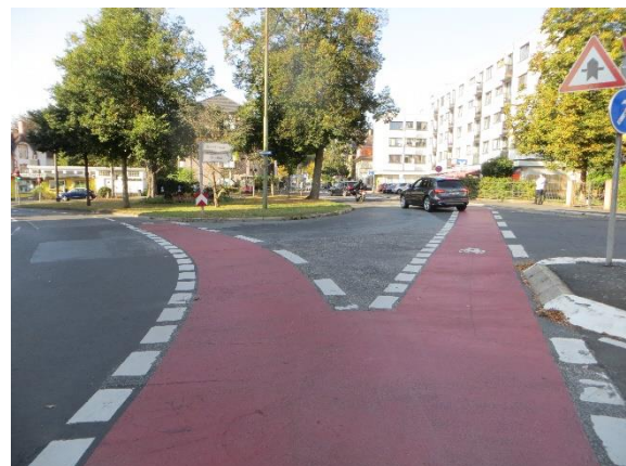
Abbildung 49: Straßenmarkierungen für den Radverkehr im Kreuzungsbereich (Schwanenallee)
