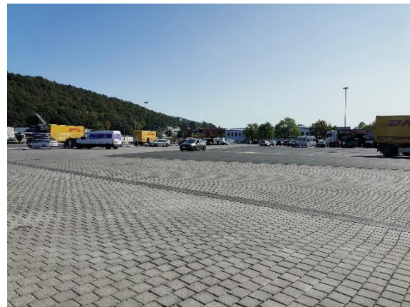
Abbildung 71: P+R Parkplatz Messeplatz
