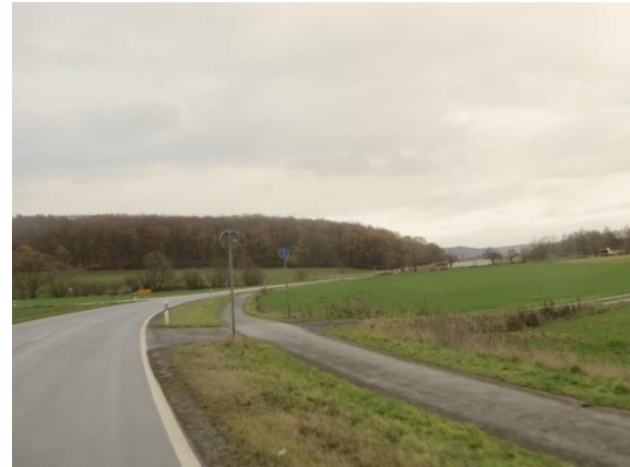
Abbildung 45: Gemeinsamer Fuß- und Radweg (Haddamshäuser Straße / L3387)
