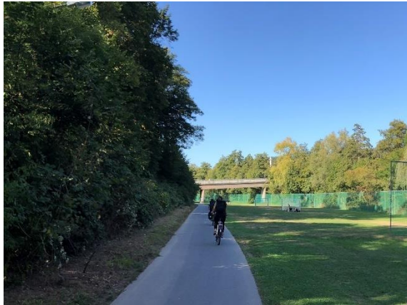
Abbildung 44: Zweirichtungsradweg und gemeinsame Führung mit Fußverkehr (Lahntalradweg)
