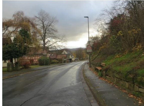
Abbildung 32: geringe nutzbare Gehwegbreite (Wehrhäuser Straße, Wehrshausen)
