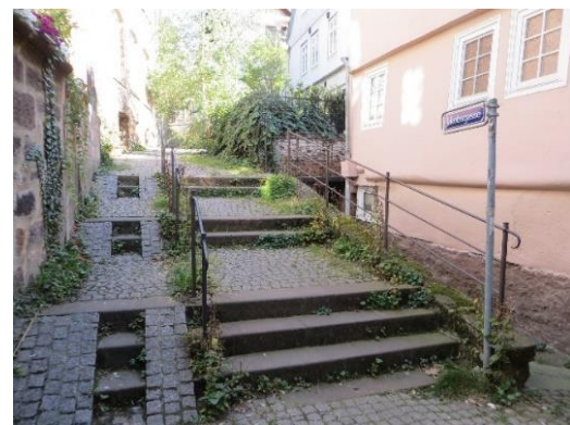
Abbildung 24: Treppenaufgang mit nicht barrierefreier Rampe (Jakobsgasse)
