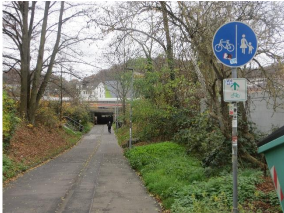
Abbildung 22: Bahnunterführung für Fuß- und Radverkehr (Alte Kasseler Straße)
