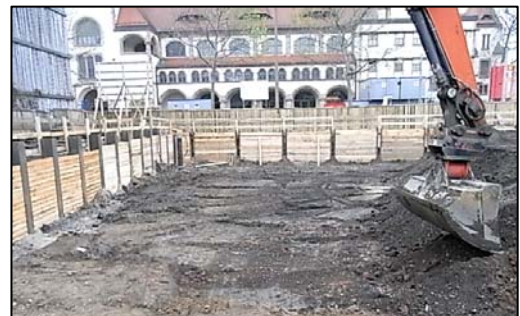
Abb. 4. Schichtenweiser Abtrag, verpflichtend bei baubegleitender KMR
