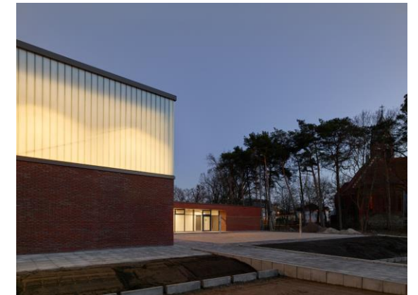
© Renner Architekten, Sporthalle Walchenseestraße
