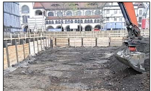
Abb. 4. Schichtenweiser Abtrag, verpflichtend bei baubegleitender KMR
