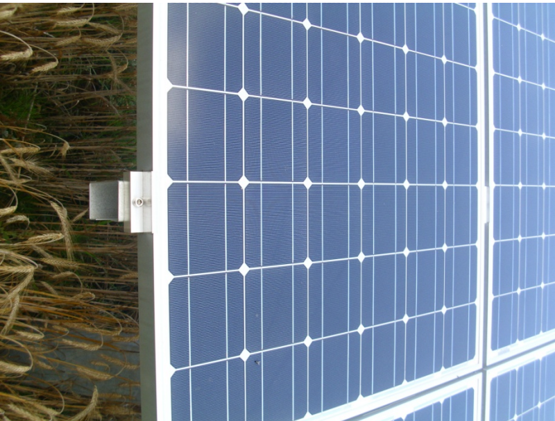
Bild 4: Modulklemme
