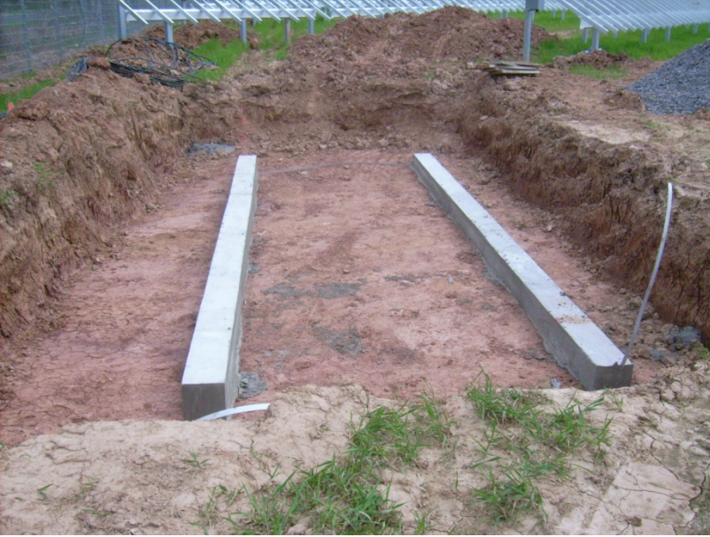
Bild 5: Transformatoren-Fundament
