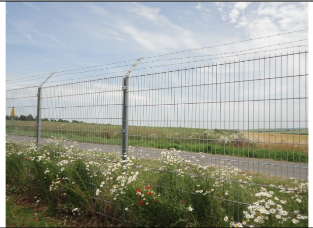
Bild 4: Zaun mit Übersteigschutz
