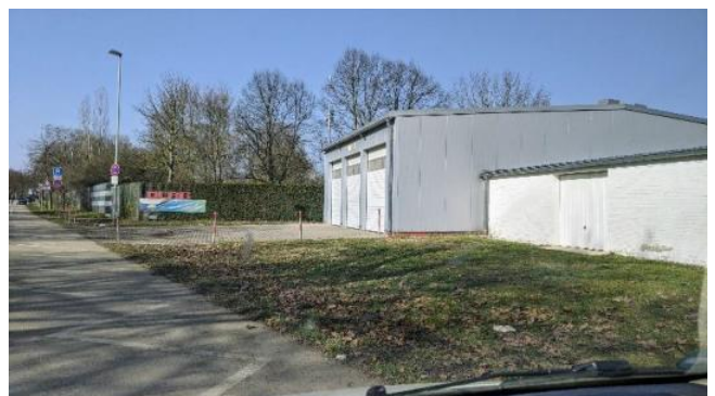
Abbildung 12: Fotodokumentation DLRG-Gebäude Weidstraße, 03/2021
