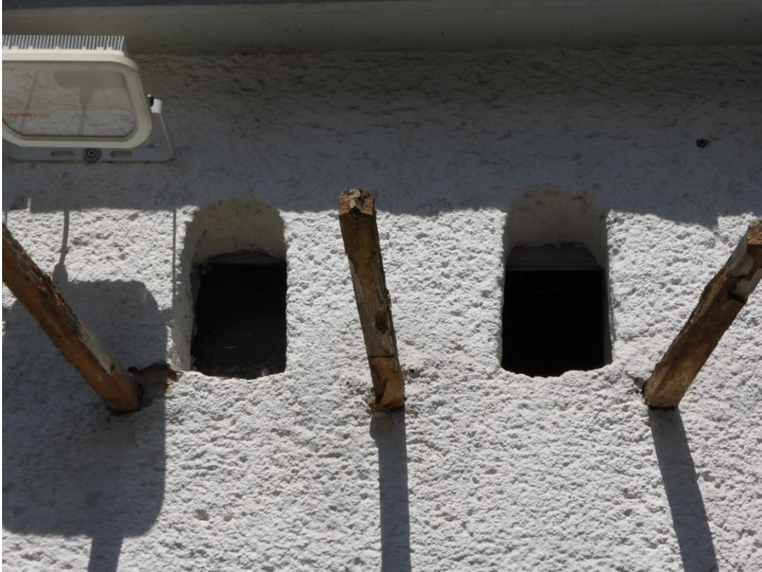
Abb. 13: Ehem. Taubeneinflug von innen verglast
