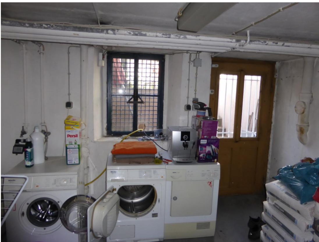
Abb. 10: Kellerräume genutzt und nach außen verschlossen
