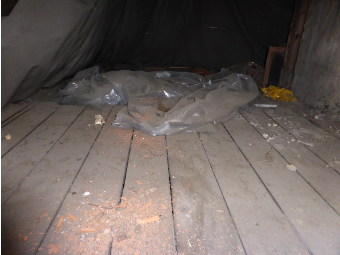
Abb. 7: Fußboden im Dachraum ohne Gewölle, Kot- oder Federreste
