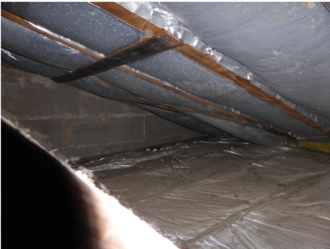
Abb. 6: Dachraum von innen, durch Isolation abgeschlossen
