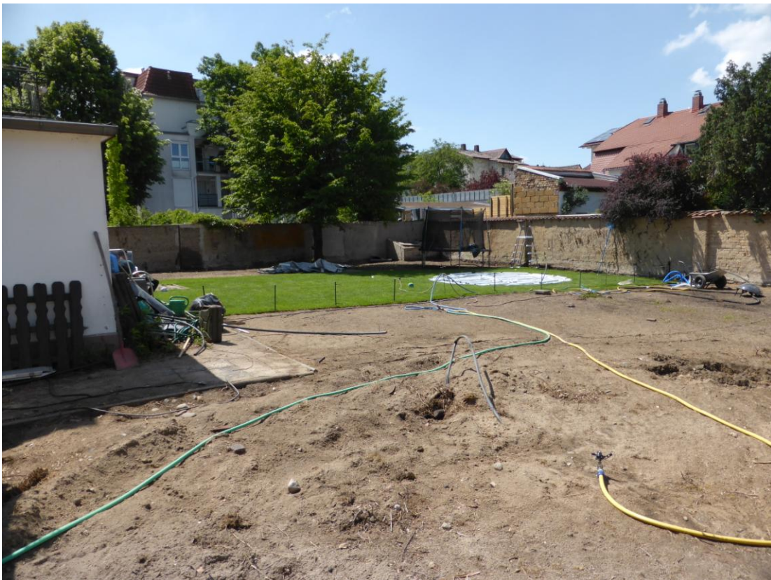
Abb. 16: Parz. 132/7, Vegetation bis auf eine Rasenfläche und einen Einzelbaum abgeräumt
