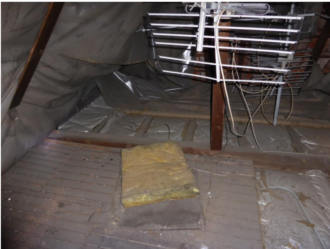
Abb. 8: Weiterer Ausschnitt des Dachraums, Befund wie Abb. 7
