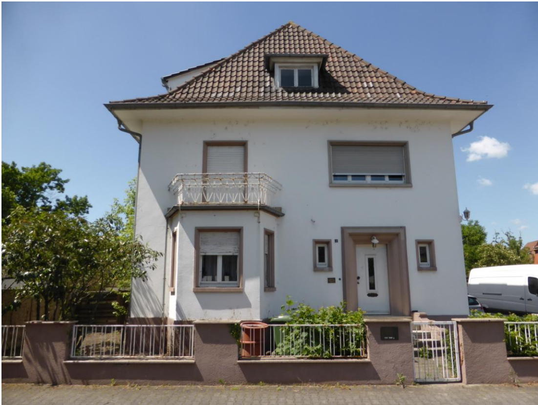
Abb. 3: Vorderansicht des Gebäudes ohne äußerliche Mauerlücken oder -spalten
