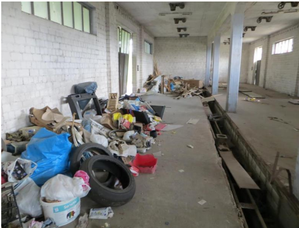
Foto 6: Innenbereich der Halle
