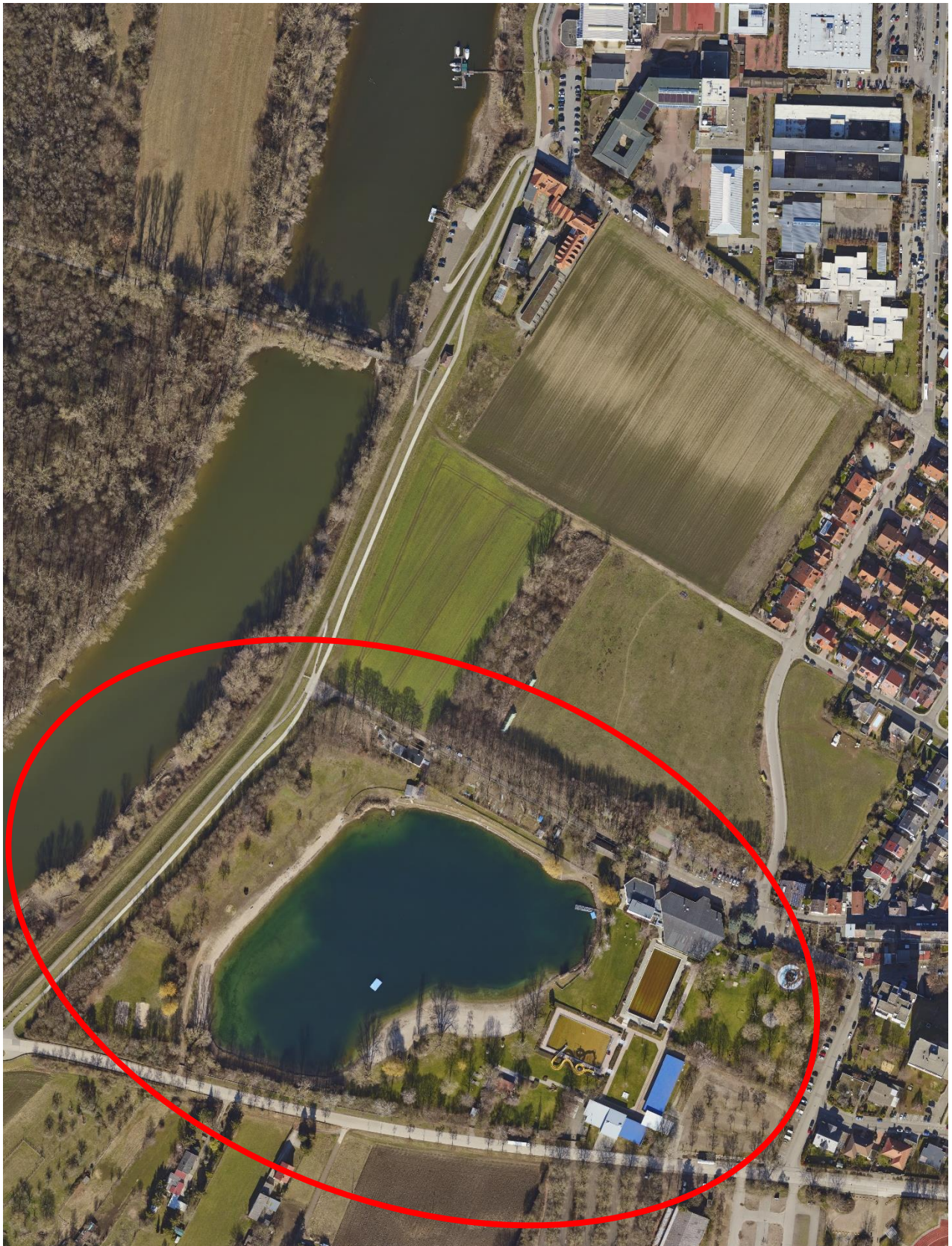
Abbildung 4: Luftbild des Plangebietes und der Umgebung (unmaßstäblich), Bildquelle: Stadt Lampertheim, Februar 2021
