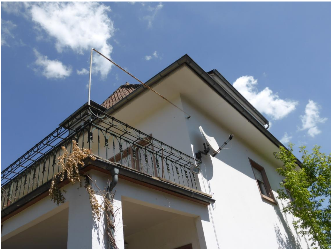
Abb. 4: Dachüberstand auf der Hinterseite, überall glatte Wandabschlüsse
