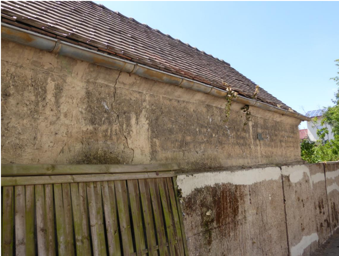
Abb. 11: Rückseite des Garagengebäudes auf Parz. 132/9
