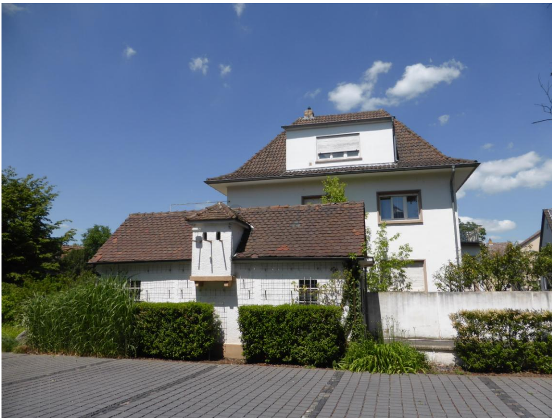
Abb. 12: Garagengebäude von gegenüber mit ehem. Taubenschlag, im Vordergrund Parkflächen
