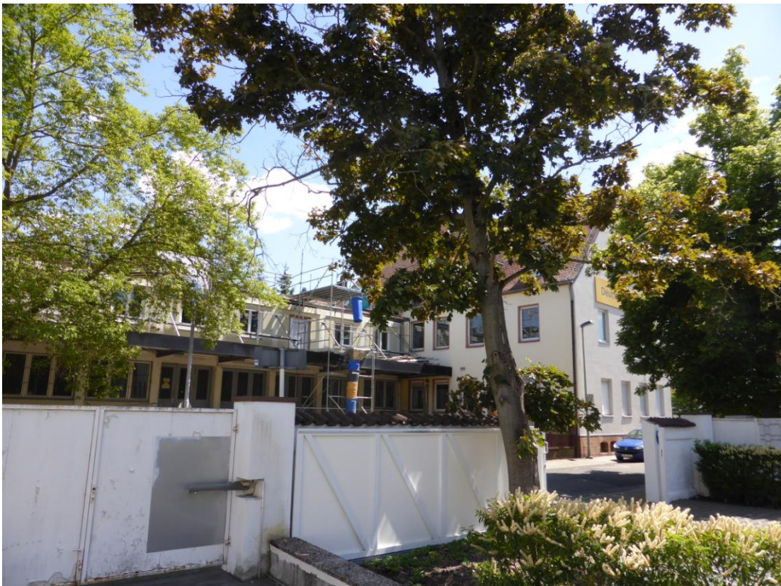
Abb. 18: Ahornbaum auf Grundstück 132/9
