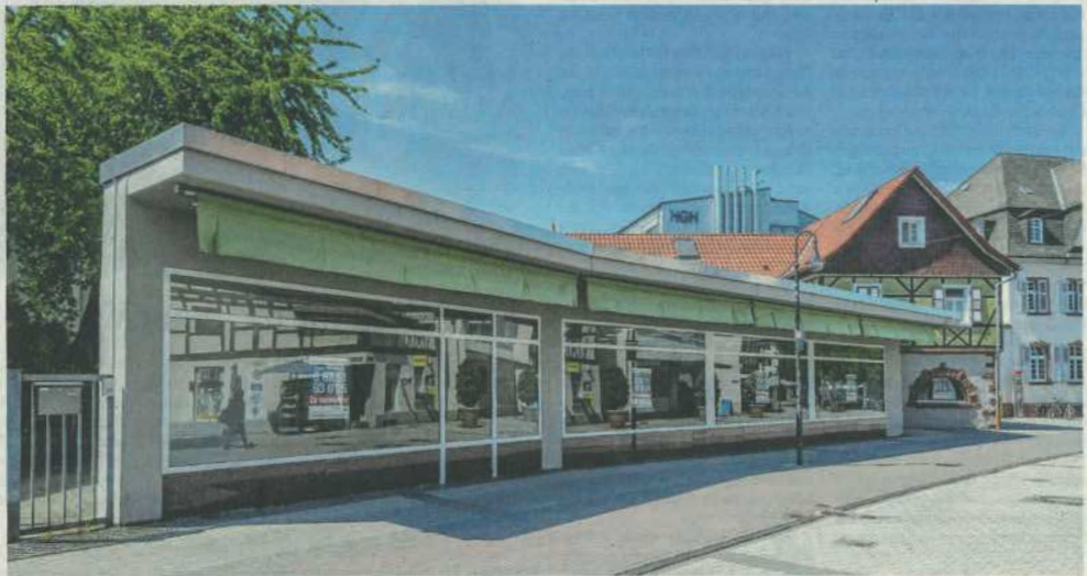
Ins ehemalige Bürohaus Werner wird ab Herbst das Familienzentrum mit einem Großteil seines breitgefächerten Angebots einziehen.
