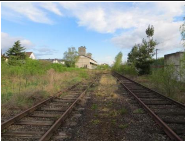
Abb. 6 a: Schotterflächen entlang der ehemaligen Gleise 2014.
