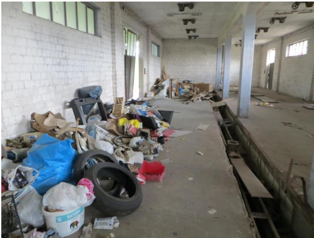
Foto 6: Innenbereich der Halle
