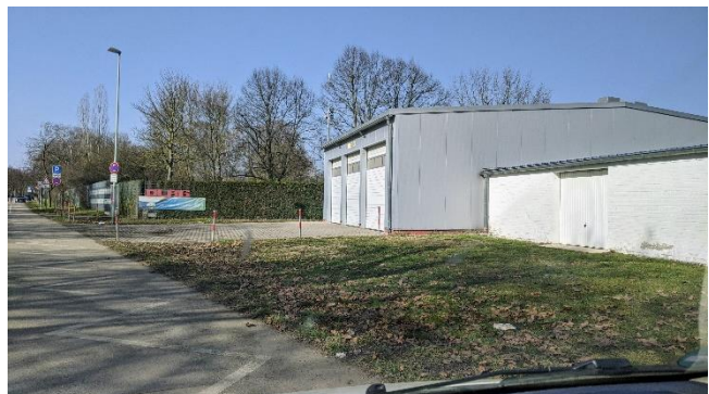
Abbildung 21: Fotodokumentation DRLG-Gebäude Weidstraße, 03/2021
