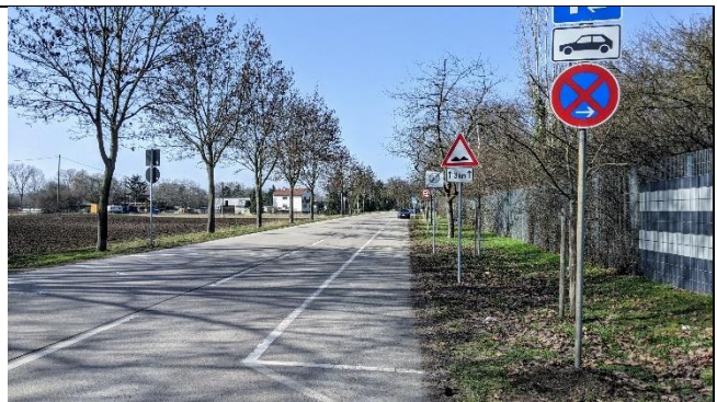
Abbildung 28: Fotodokumentation Weidstraße mit begleitender Allee
