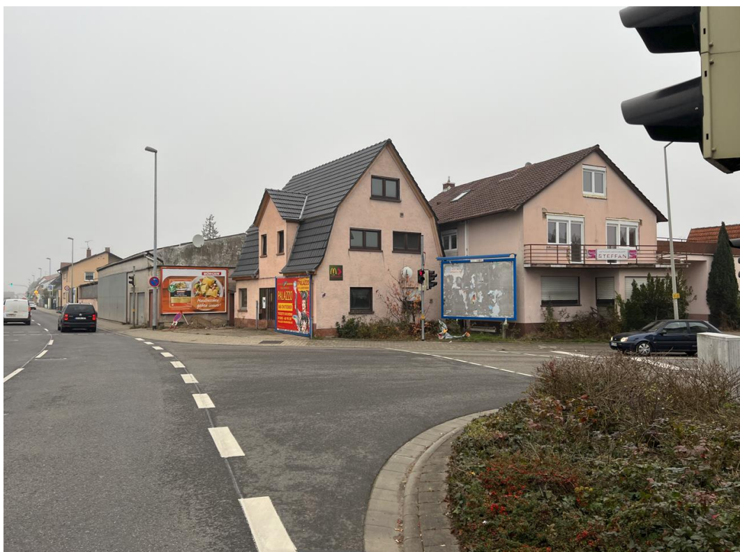
Bild 10: Blick von Süden auf den Gebäudekomplex vor Durchführung der Abrissarbeiten im Jahr 2022
