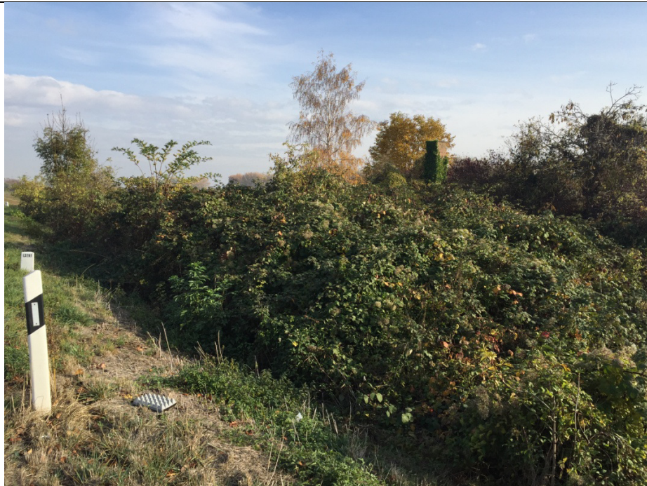
Bild 2: Blick von der südwestlichen Ecke des Standortes von der Hofheimer Straße aus. Rechts von der Bildmitte aus ist der Kamin der ehem. Heizanlage zu erkennen (09.11.2018 / Blickrichtung: NE)
