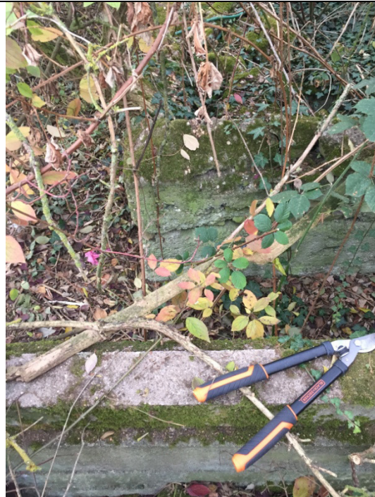
Bild 8: Detailfoto: Fundamente aus Bild 7 (09.11.2018)
