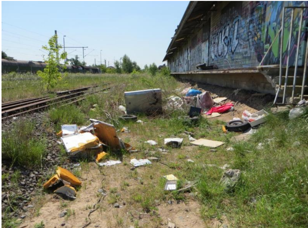
Foto 1: Abfallablagerungen entlang des östlichen Hallenrandes.
