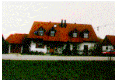
Foto Positivbeispiel Doppelhaus mit harmonisch in die Dachfläche eingefügten Gauben von gleichmäßiger Form und Größe
