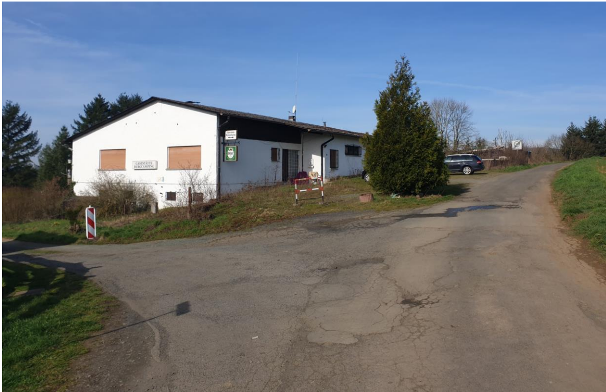
Foto 1: Blick auf ehemalige Gaststätte des Campingplatzes (Aufnahme: Ingenieurbüro Zillinger, März 2020)
