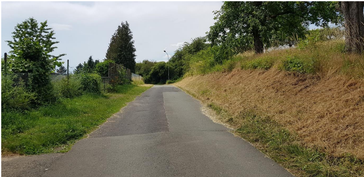
Foto 5: Hermann-Löns-Weg (Aufnahme: Ingenieurbüro Zillinger, März 2020)
