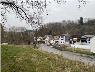
Bebauung vor ehemaligem Tunnelportal (Haus mit Türmchen)
