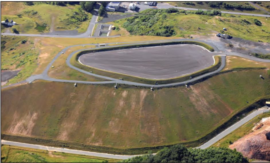
Abbildung 8: Oberflächenabdeckung im Deponieab- schnitt B3 2016.
