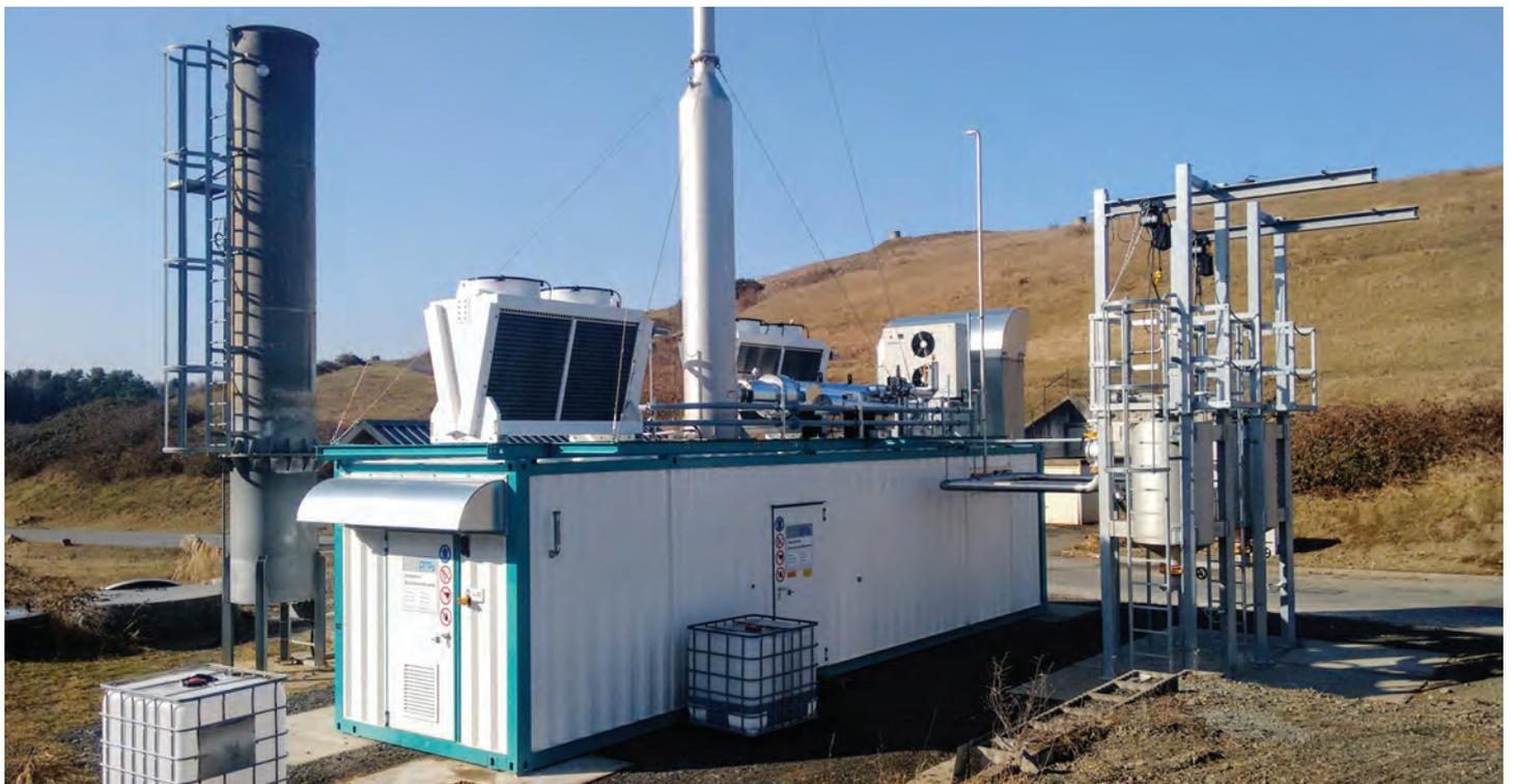
Abb. 6: Das 2016 erneuerte Blockheizkraftwerk (BHKW) zur Deponiegasverwertung. Das BHKW wird vom Abfallwirtschaftsbetrieb ab 2017 in Eigenregie betrieben.
