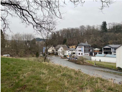
Bebauung vor ehemaligem Tunnelportal (Haus mit Türmchen)
