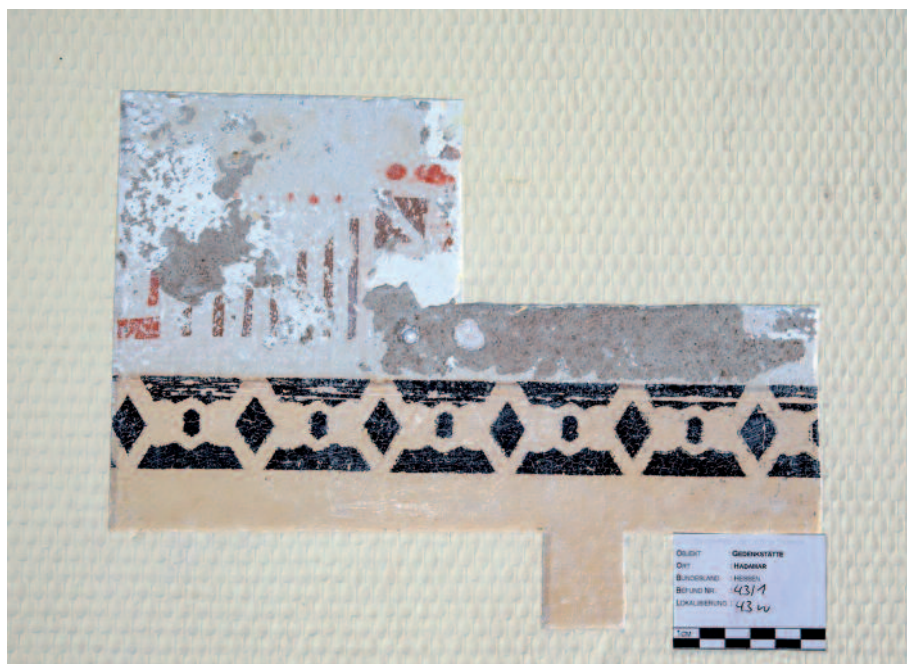
Eine bei restauratorischen Untersuchungen der Wände des Westflügels freigelegte Borte. Foto: Sven Trommer, 2019
