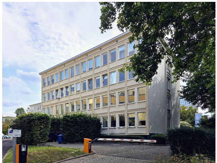
Abbildung 11: Ansicht Fassade mit Zufahrt
