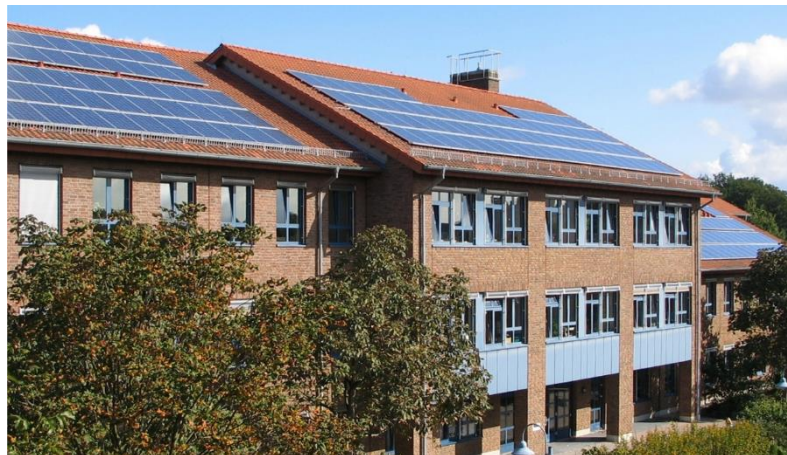
Abbildung 24: JPSS mit der PV-Anlage
