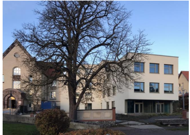
Abbildung 26: HSS Altbau und Neubau
