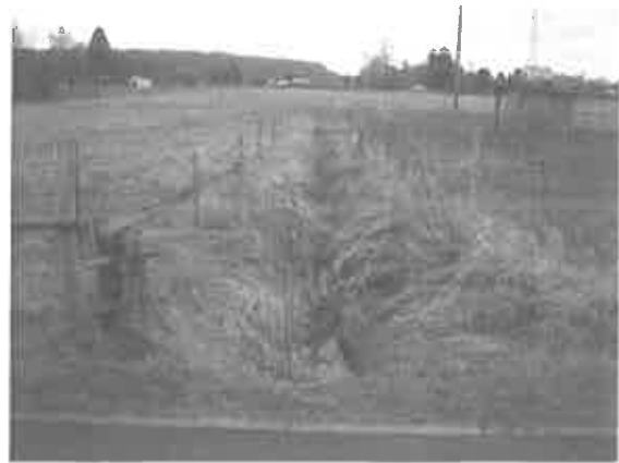
Abb. 4: Grabenbereich, Blick von Norden
