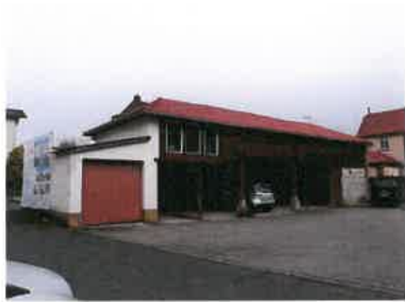
Bild 2: Remise zur Bahnhofstraße hin
