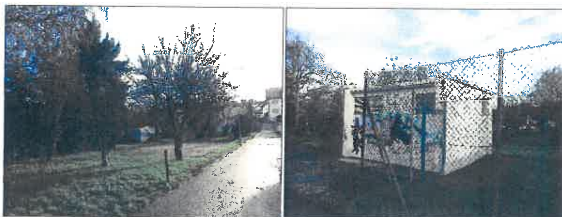
Abb. 5: Boule-Platz (links) und Gebäude (rechts).
