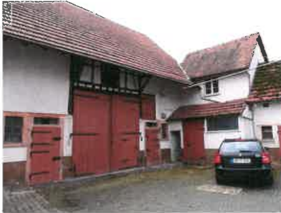
Bild 1: Bahnhofstr. 30, Hofreite, Stallgebäude
