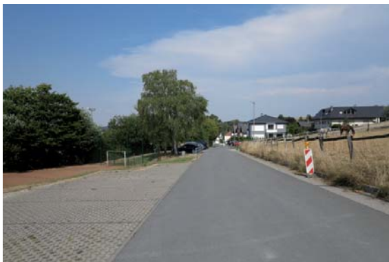
Abb. 48: Blick aus Südwesten entlang der FLJ Straße
