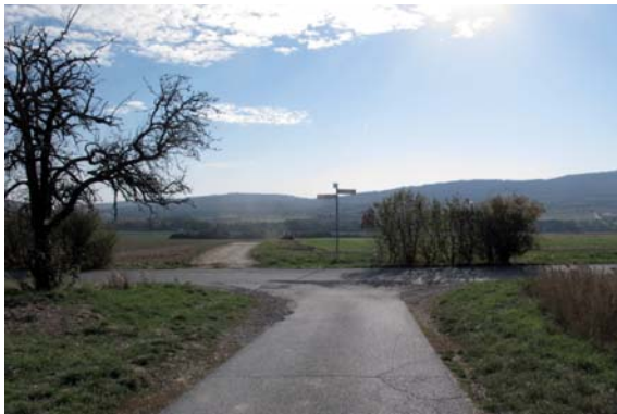
Abb. 28 Blick auf die im Süden angrenzende Kreisstraße
