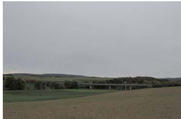
Abb. 78: Blick über Plangebiet aus Nordwesten
