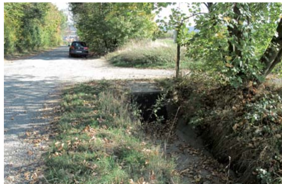
Abb. 59: Retentionsgraben am nördlichen Rand des Plangebietes
