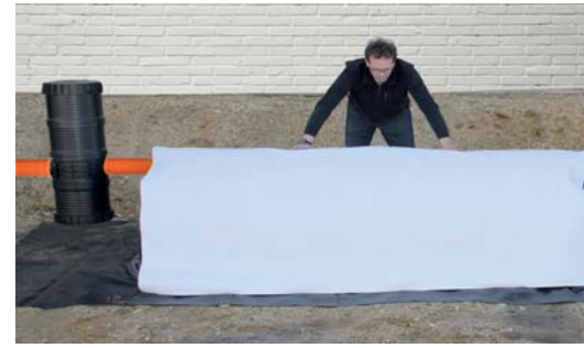
Tunnel mit GT-300 abdecken
