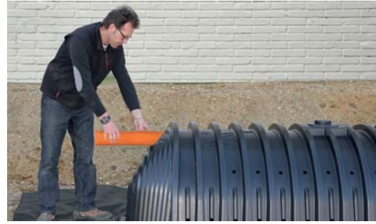
RW Zulaufrohr montieren
