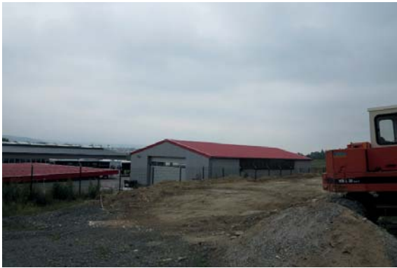
Abb. 95: Blick über Plangebiet aus Süd-Westen
