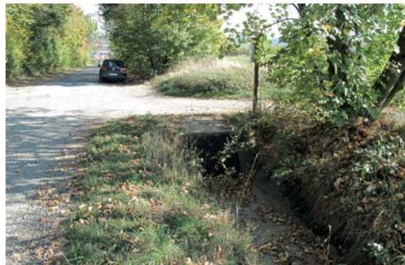
Abb. 59: Retentionsgraben am nördlichen Rand des Plangebietes
