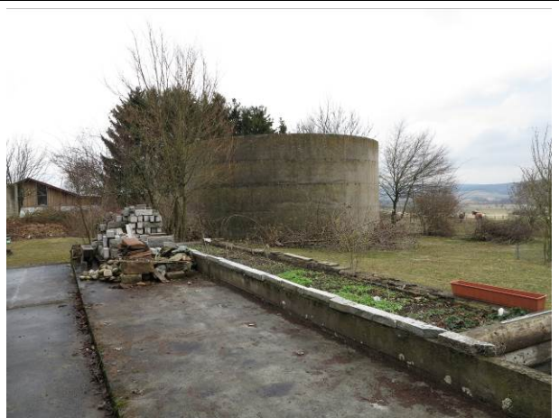
Bestehendes Silo – geplante Umnutzung zum Wohnen
