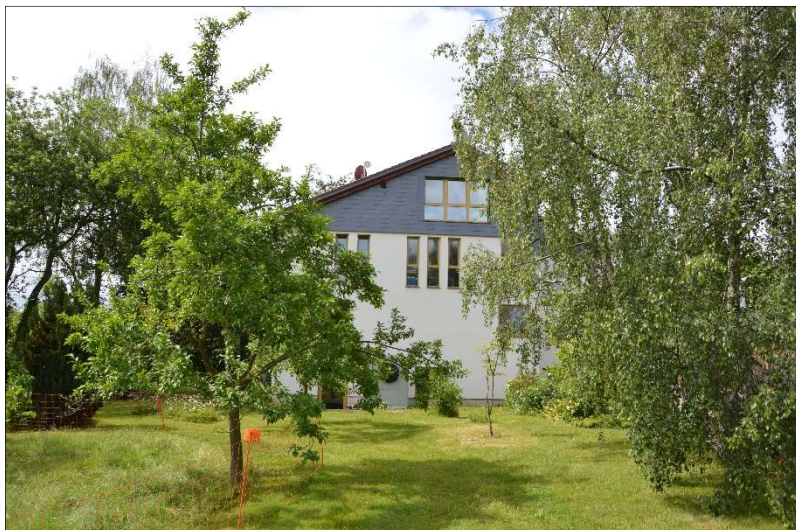
Abb. 3: Blick durch den Garten auf das Wohnhaus.
