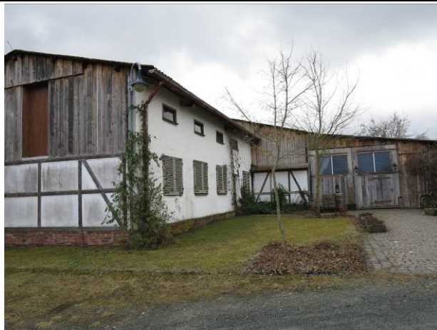
Scheune und Zugang zum Gastraum
