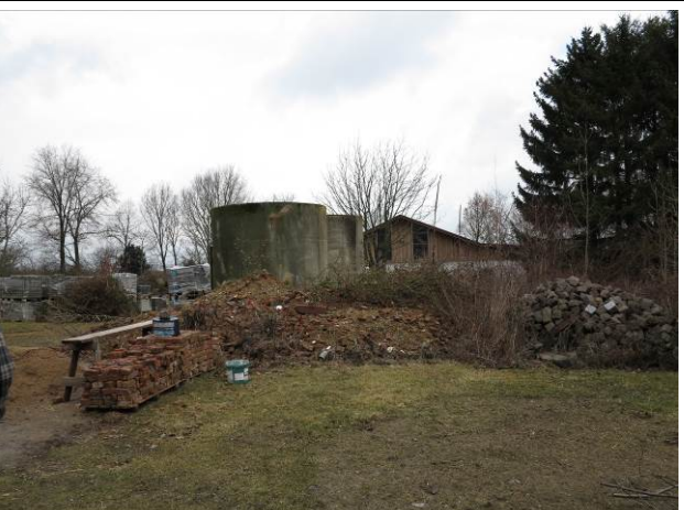
Bestehende Kleinsilos – geplante Umnutzung zur Wohnnutzung, im Hintergrund der Pferdestall
