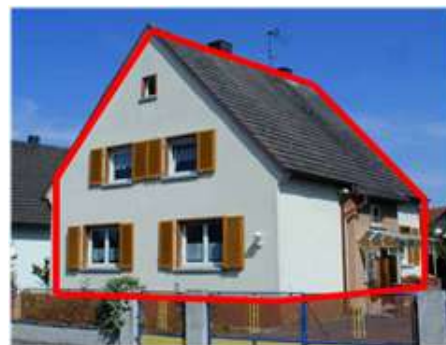
Abb. 54: Beispielhaus für umfassende Sanierung
