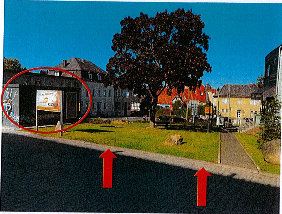
Ostansicht Grundstück mit Trafohaus
