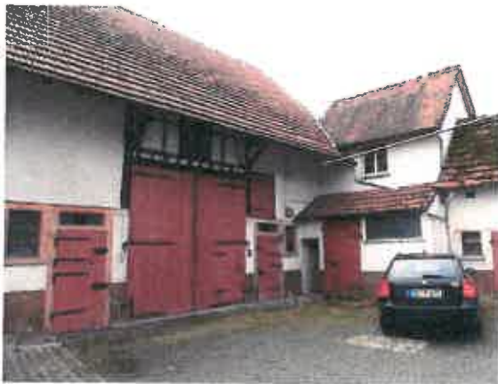
Bild 1: Bahnhofstr. 30, Hofreite, Stallgebäude
