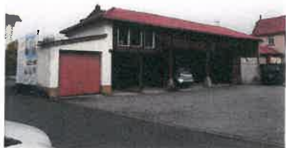
Bild 2: Remise zur Bahnhofstraße hin
