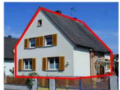
Abb. 54: Beispielhaus für umfassende Sanierung
