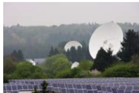
Abb. 2: Photovoltaik-Freiflächenanlagen auf der Erdfunkstelle Usingen 3
