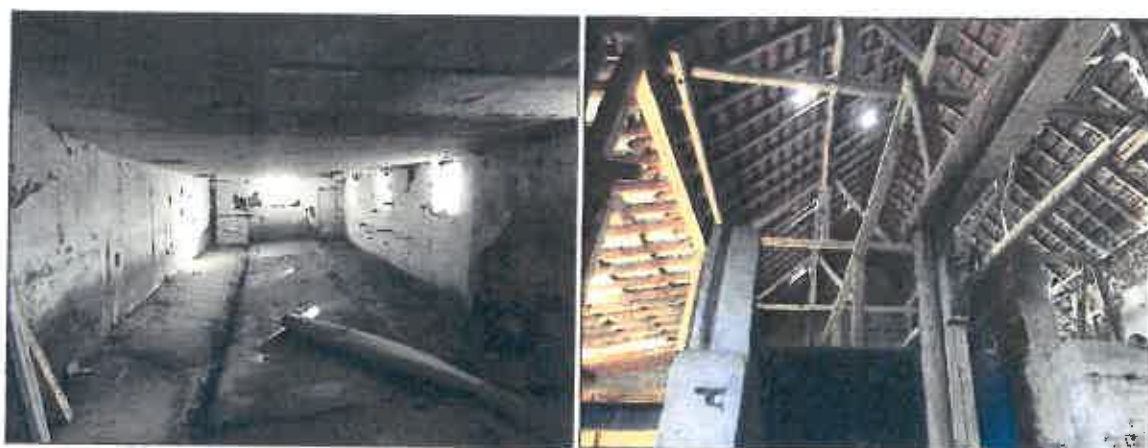
Abb. 4: ehem. Schweinestall (links) und Scheunengebälk (rechts).
