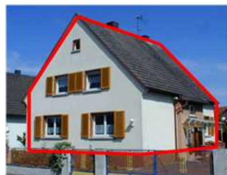
Abb. 54: Beispielhaus für umfassende Sanierung
