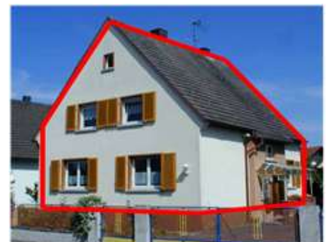
Abb. 54: Beispielhaus für umfassende Sanierung
