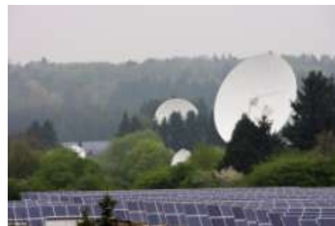
Abb. 2: Photovoltaik-Freiflächenanlagen auf der Erdfunkstelle Usingen 3
