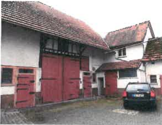
Bild 1: Bahnhofstr. 30, Hofreite, Stallgebäude
