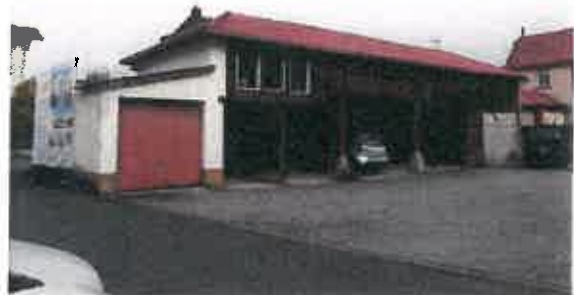
Bild 2: Remise zur Bahnhofstraße hin
