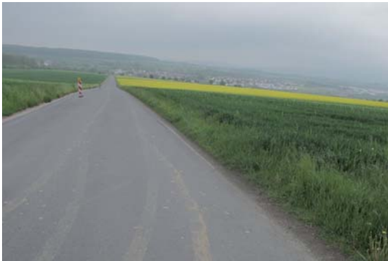
Abb. 102: Blick über Plangebiet entlang der Erschließungsstraße
