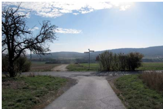
Abb. 28 Blick auf die im Süden angrenzende Kreisstraße
