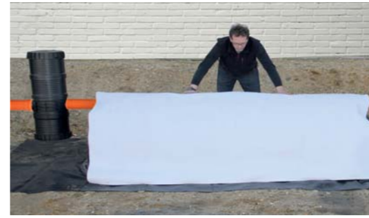
Tunnel mit GT-300 abdecken
