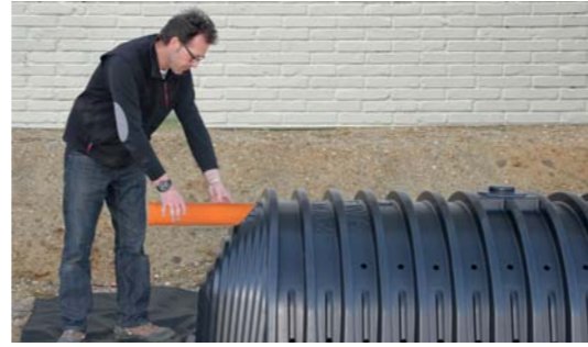
RW Zulaufrohr montieren
