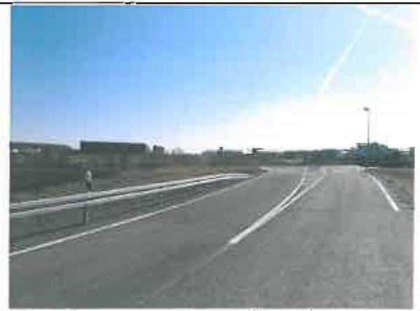
Heisterbachstraße Blickrichtung Kreisverkehr
