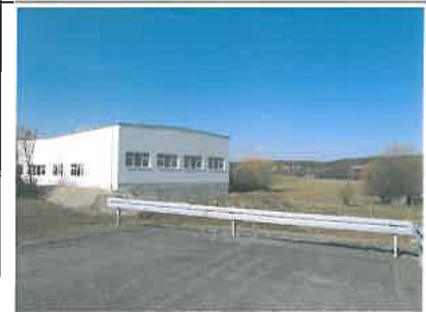
Übergangsbereich Heisterbachstraße 3. BA und 4. BA und die neu errichtete Fertigungshalle
