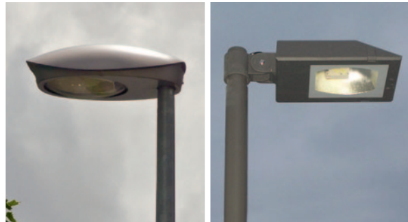
Optimale Leuchten: voll abgeschirmt, mit flachem Schutzglas und waagrecht montiert
