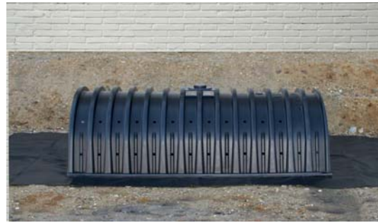
Tunnel Rigole auf GTVB 190 setzen
