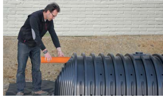
RW Zulaufrohr montieren
