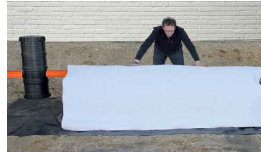
Tunnel mit GT-300 abdecken
